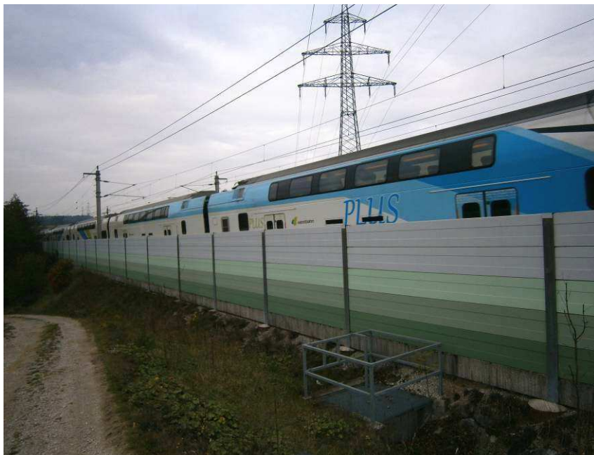
Wenigstens im Obergeschoß ist der Blick über die Lärmschutzwände möglich.
