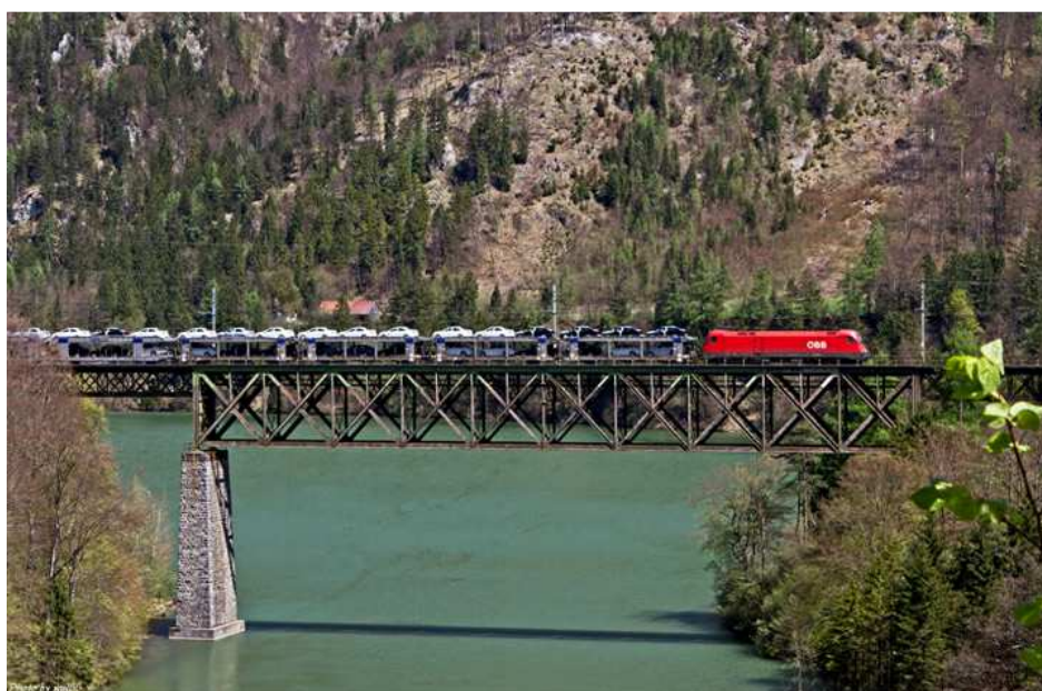
Bild: rail66, Pyhrnbahnbrücke über die Steyr
