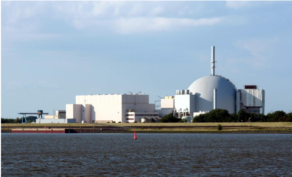
Atomkraftwerk Brokdorf, Deutschland Bild: Wikipedia
